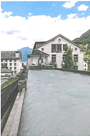
Das arealeigene Wasserkraftwerk in Diesbach sorgt für Einkünfte, solange die Gebäude leer stehen.
