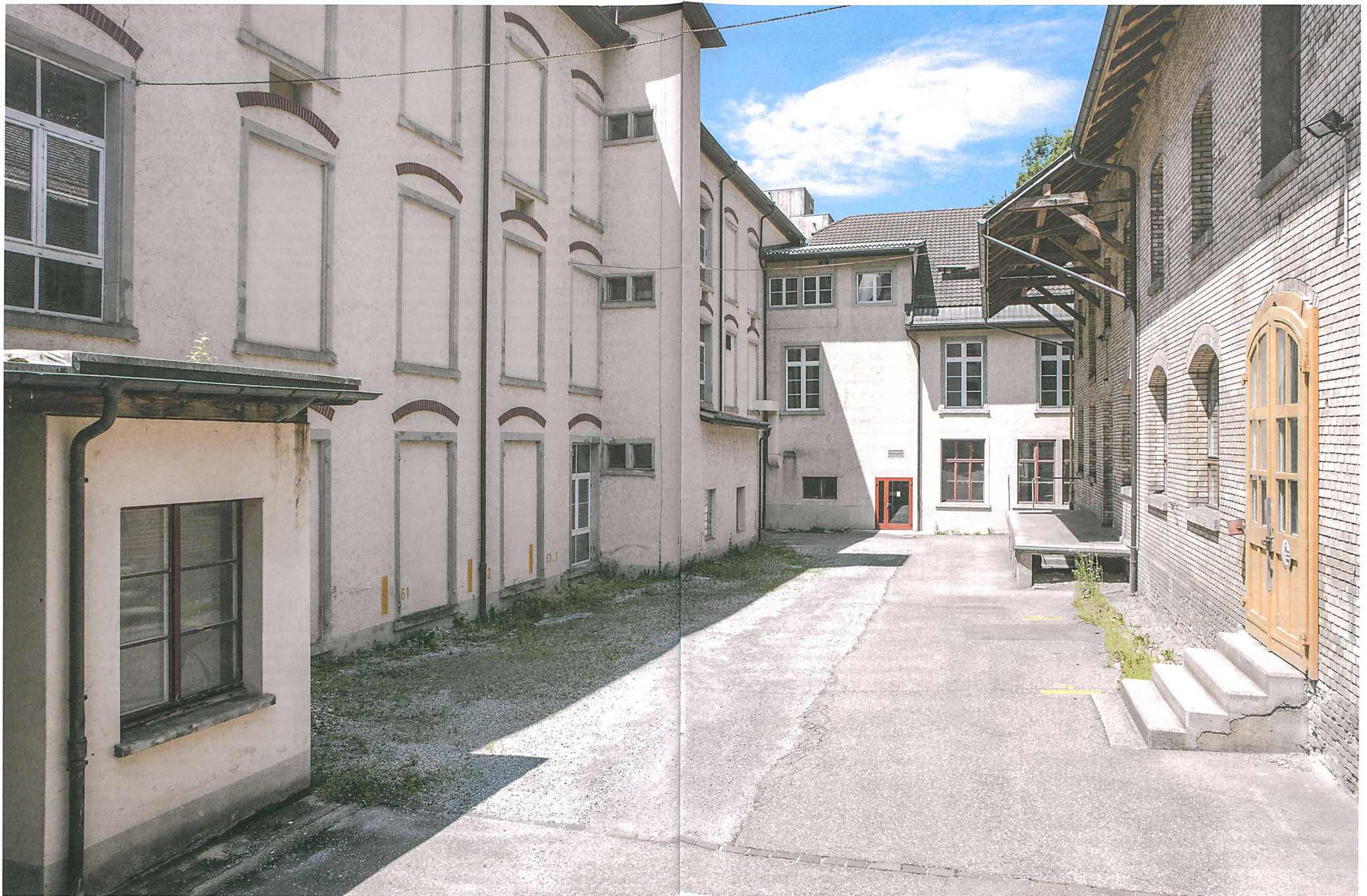
Die ehemaligen Fabrikhallen der Baumwollspinnerei auf dem Floos-Areal in Wetzikon sollen in Wohnungen, Büros und Läden umgenutzt werden.
