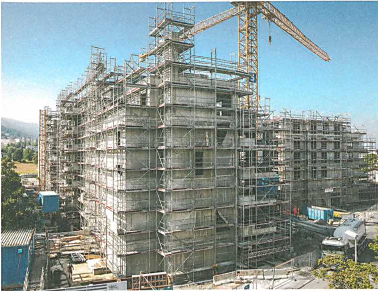
Nach dem Ausrüsten werden die Häuser mit einem eleganten Putz-Klinker-Mantel eingekleidet.
