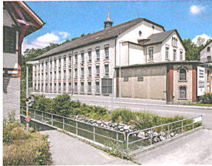
Die Umnutzung der Spinnerei Floos wird als nächstes Projekt realisiert.
