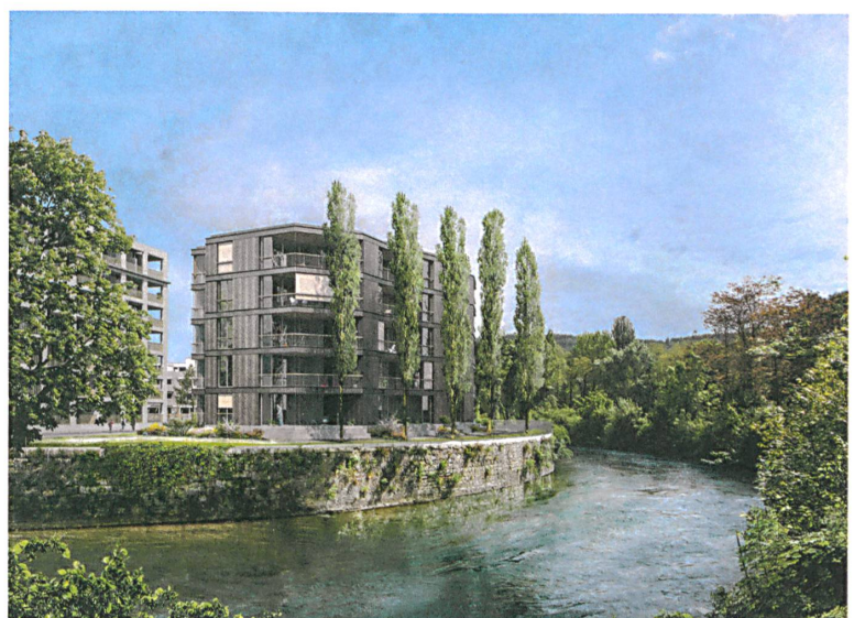
Die dunklen Profilbleche der Fassaden sollen an die historischen Wehranlagen im Kanal erinnern.
