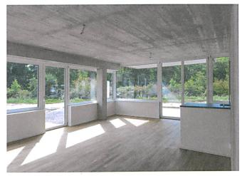
Stütze, Balken und Decke aus Beton bilden ein Tragsystem. Es lässt den freien Einbau der Räume zu.
