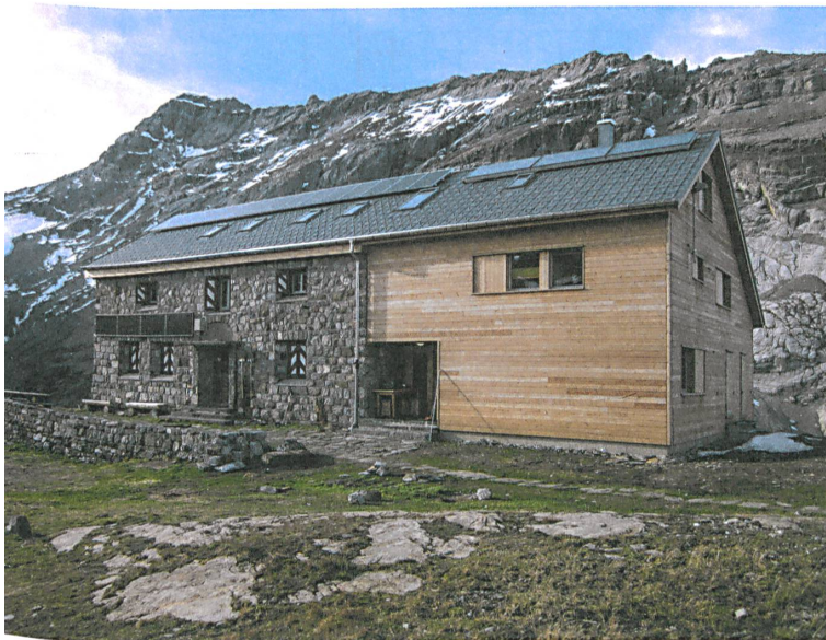
12 Holz ergänzt die alten Steinmauern der Claridenhütte. | Wood enhances the old stone walls of the Clariden chalet.
