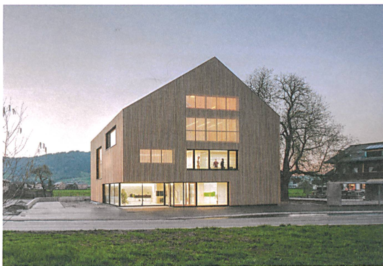
26 Ein Holzvorhang verkleidet den Neubau. | New construction with a wooden curtain.
