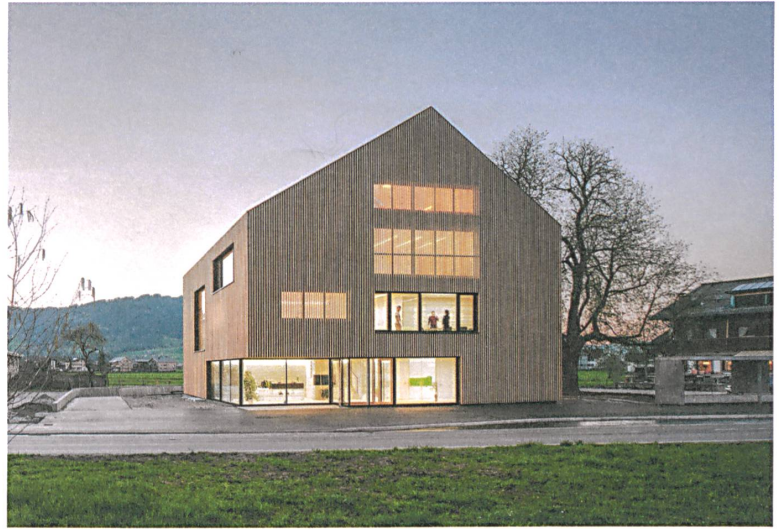
26 Ein Holzvorhang verkleidet den Neubau. | New construction with a wooden curtain.
