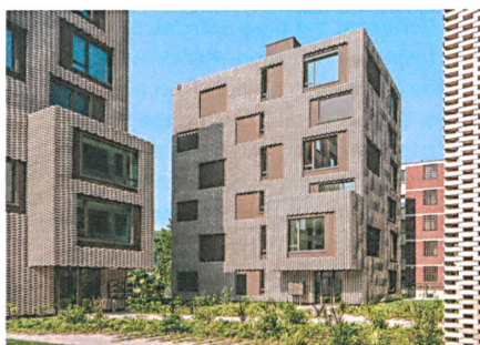
Die Ziegelhaut und die Kompaktfassade darunter stimmen absichtlich nicht genau überein.
