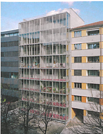
Eine ganzflächig verglaste Loggiaschicht prägt die Hofseite.
