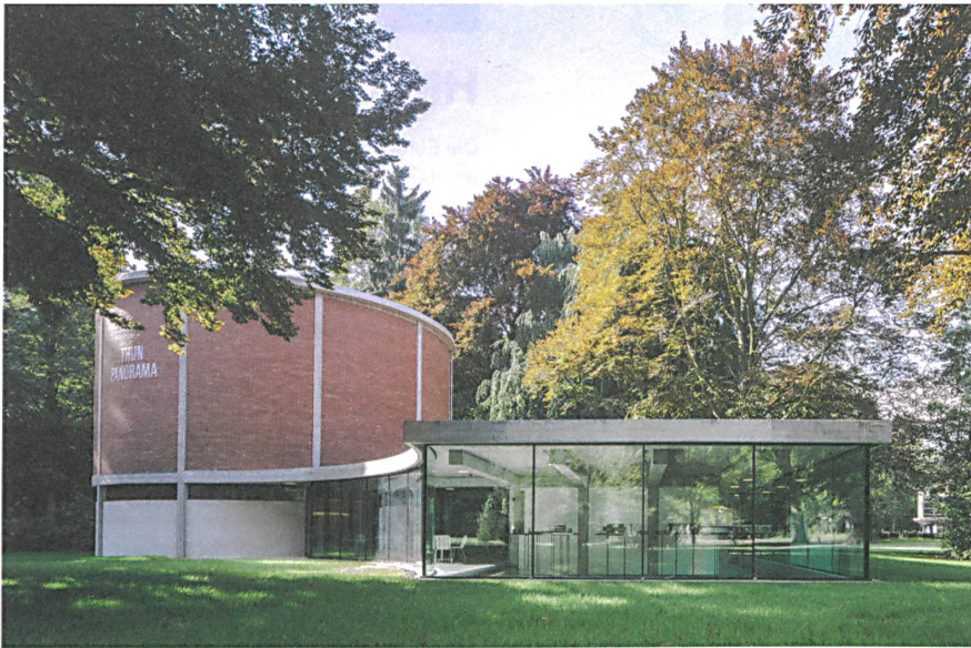
Mit dem neuen Anbau öffnet sich der Ausstellungsraum des Thun-Panoramas zum Park am See.
