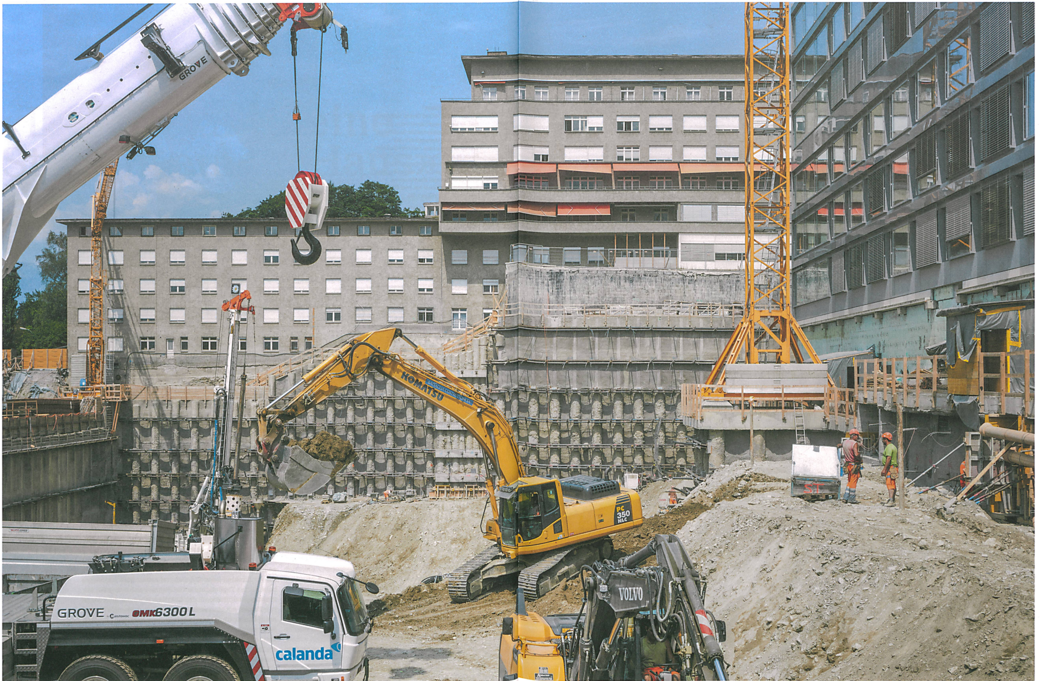
Es war Churs grösste Baugrube. Daraus wächst das neue Kantonsspital Graubünden.
