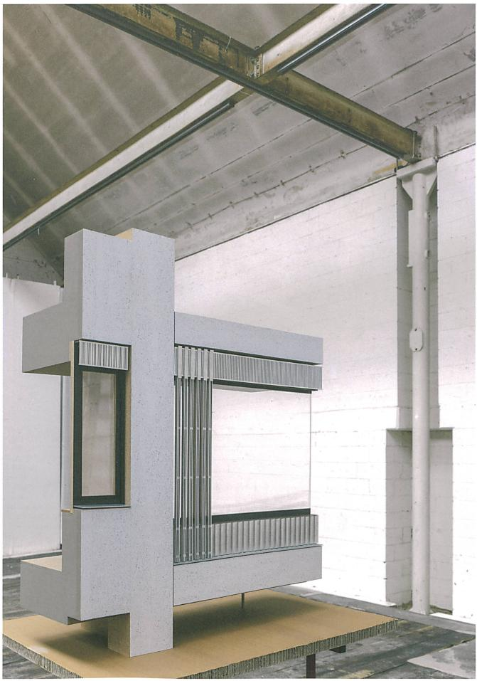
Das Spital entsteht zweimal: Bevor es aus der Baugrube wächst, konstruieren die Architekten jedes wichtige Detail im Modell. Hier das Broschenfenster entlang der Loëstrasse.
