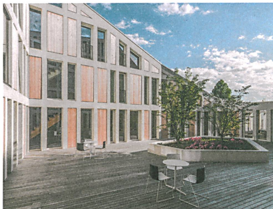
Die Gebäudeform ermöglicht eine optimale Besonnung des Innenhofs.
