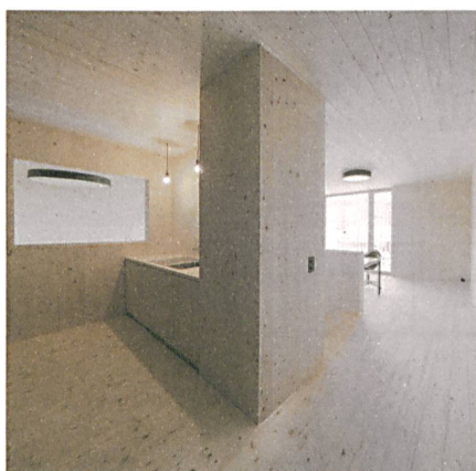
Der Bürokubus ist mit Massivholzelementen konstruiert.
