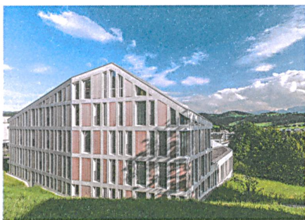
Die Fassaden interpretieren das Appenzeller Bandfenster gekonnt neu.
