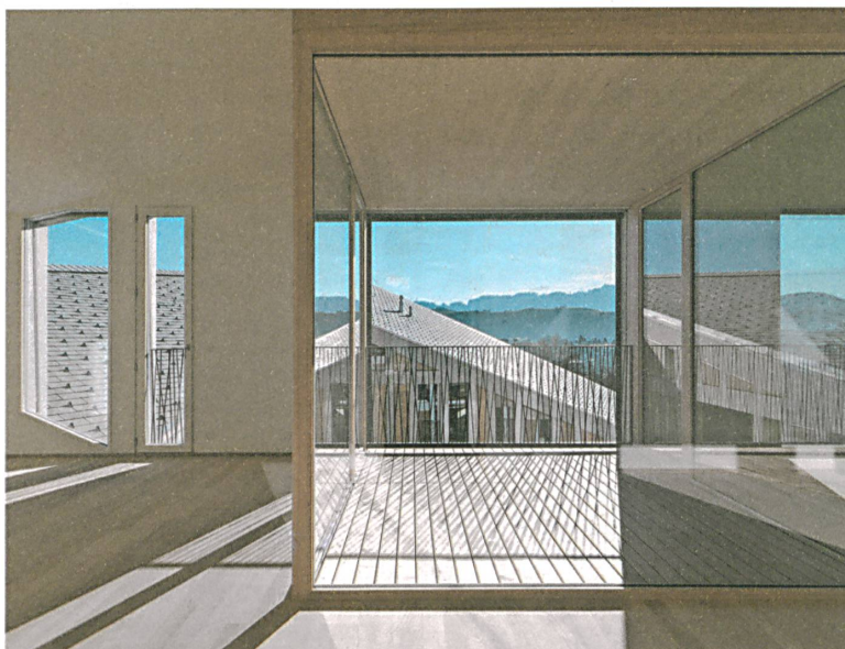
Die Böden, die Türen und die Rahmen der Loggien sind aus geölter Eiche oder Esche konstruiert.
