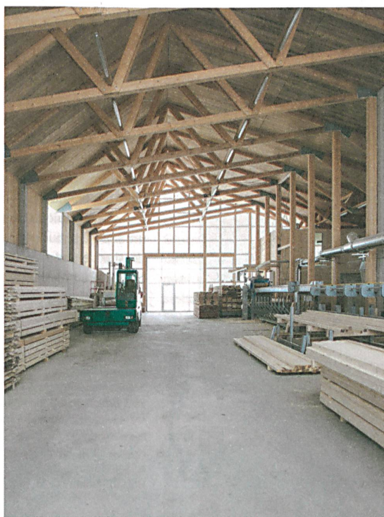
Kräftige Fachwerkträger überspannen die zweischiffige Halle.
