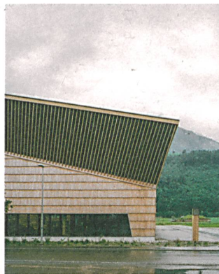
Die auskragende Fassade schützt die Holzschindeln.
