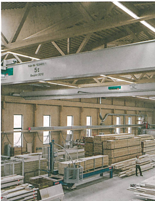
Alles ist aus Holz konstruiert, selbst der Balken, auf dem der Kran hin und her rollt.
