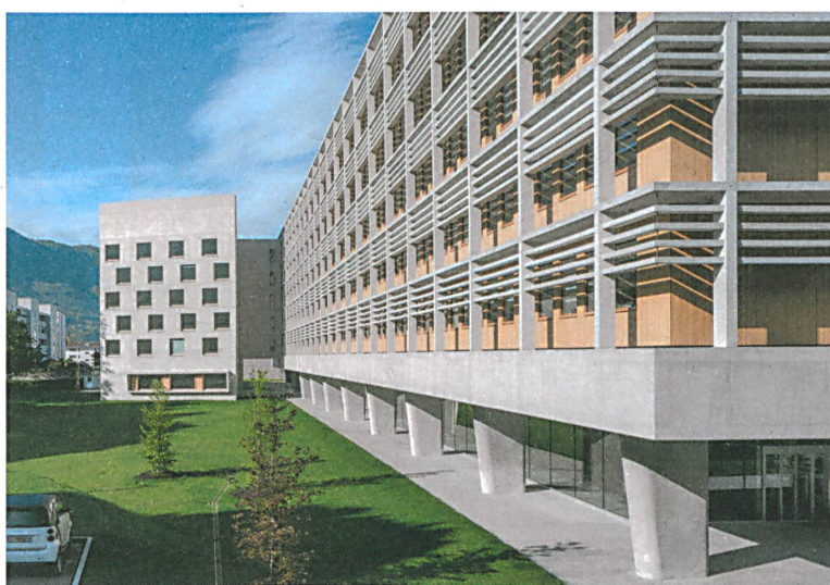
37 Nell'edificio per uffici di Bellinzona, il cemento si fonde con la modernità del legno.
