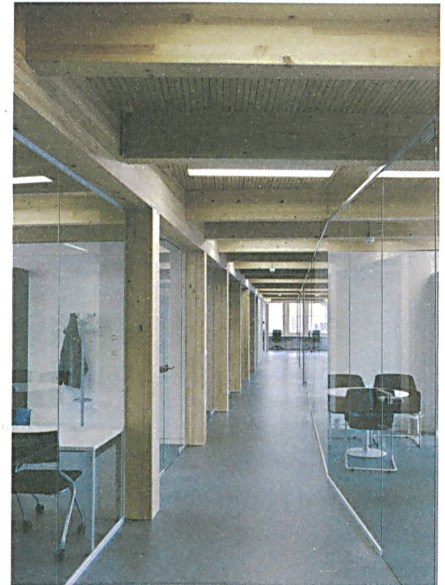
31 Die sichtbaren Rippen, die von den Stützen der Aussenwand bis zu einem Mittelbalken spannen, prägen die Innenräume.
