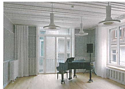
27 Das Täfer moduliert die Akustik in den Übungszimmern.
