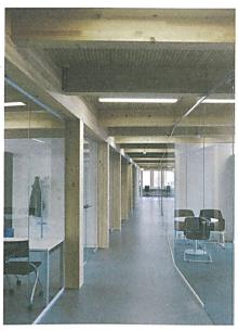
31 Die sichtbaren Rippen, die von den Stützen der Aussenwand bis zu einem Mittelbalken spannen, prägen die Innenräume.
