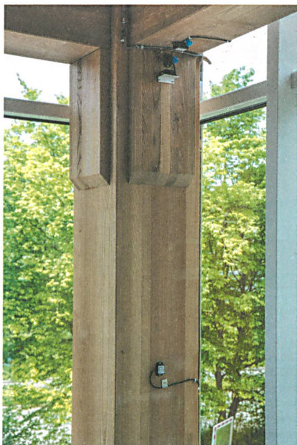
Sensoren überwachen das Tragwerk aus Esche.
