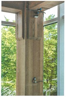
Sensoren überwachen das Tragwerk aus Esche.
