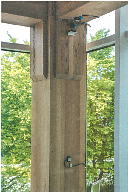
Sensoren überwachen das Tragwerk aus Esche.
