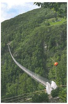
Betonblöcke verankern die filigrane Konstruktion im Fels
