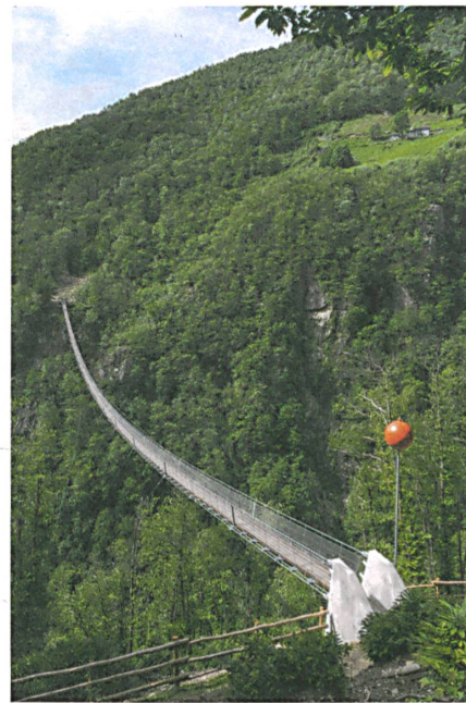
Betonblöcke verankern die filigrane Konstruktion im Fels.
