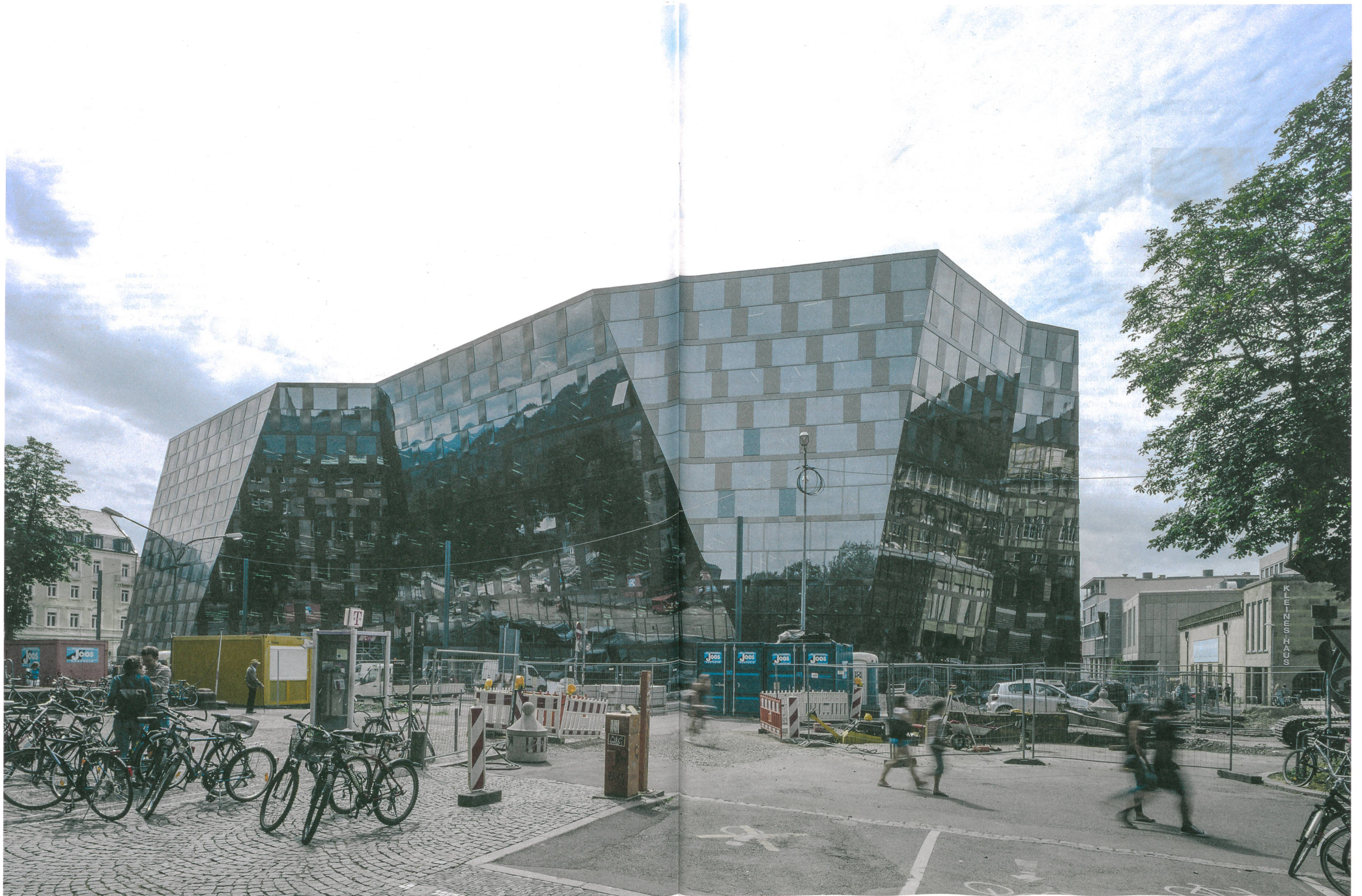
Universitätsbibliothek von Freiburg im Breisgau: Die Fassade besteht aus 14 Teilen, und kein Fassadenteil ist lotrecht. Blick vom gegenüberliegenden Platz der Alten Synagoge.
