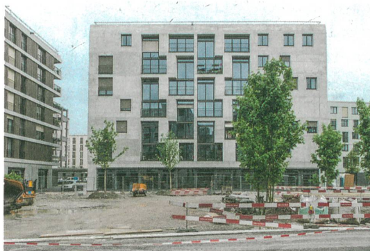
Das Haus besteht aus monolithischem Dämmbeton.
