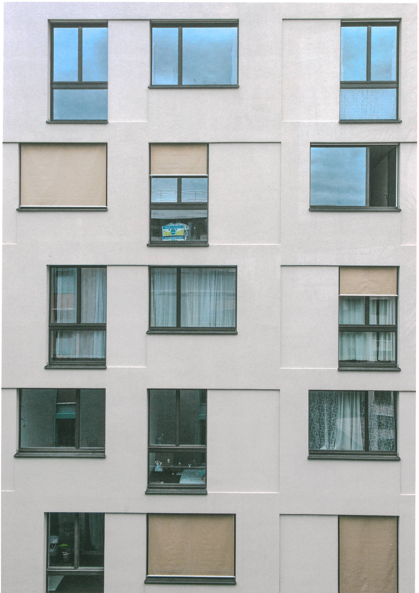
Putz auf Wärmedämmung, verschieden tief, verschieden gekörnt.
