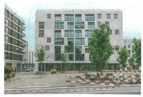
Das Haus besteht aus monolithischem Dämmbeton.
