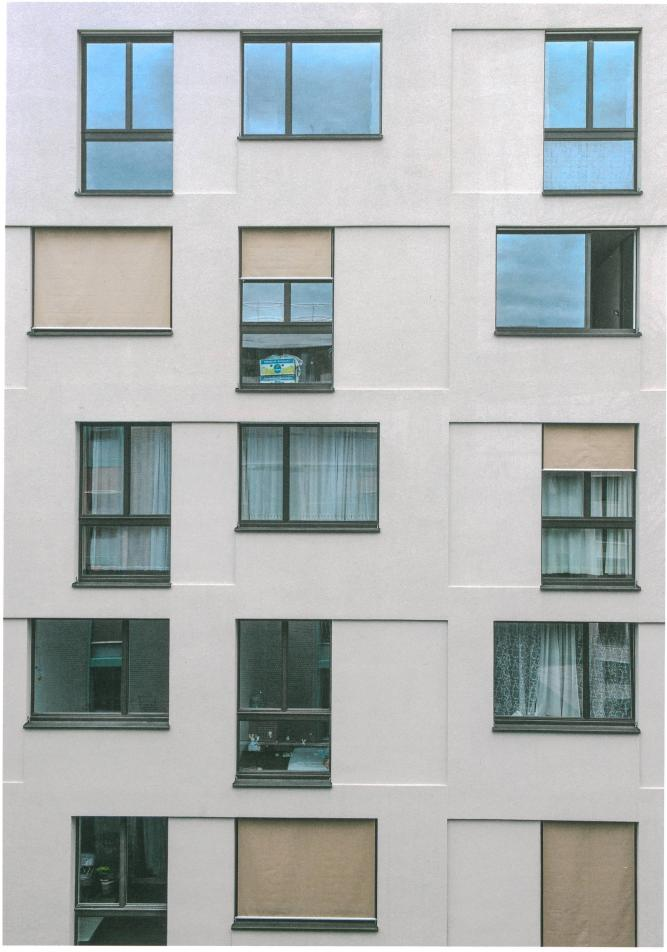
Putz auf Wärmedämmung, verschieden tief, verschieden gekörnt.
