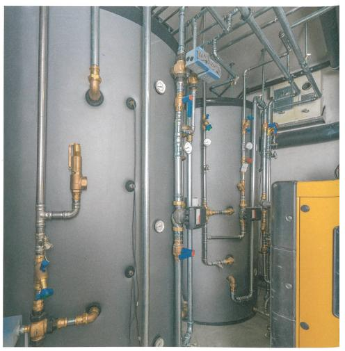
Solarspeicher und Warmwasserverteilung mit den Systemen (Optipress-Aquaplus) und (Optipress-Therm) von Nussbaum. | Accumulateurs solaires et distribution d'eau chaude intégrant les systèmes Optipress-Aquaplus et Optipress-Therm de Nussbaum.
