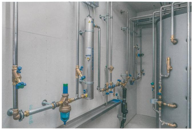
Das Herzstück: Wasser filtern, reduzieren, sichern und verteilen, i La pièce maîtresse: filtrer, réquier, assurer et distribuer l'eau,
