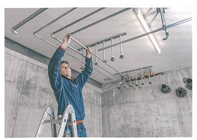
Dominic van Deuren montiert Rohre im System (Optipress-Aquaplus). |
