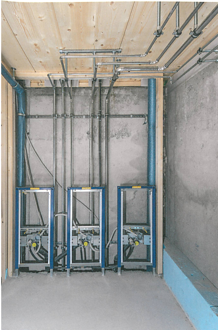
Steigzonen und Verteilleitung aus Edelstahl mit Pressfittings. | Des tuyaux en acier inoxydable à sertir composent les colonnes montantes et les conduites de distribution.
