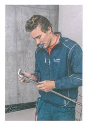
Der Installateur Dominic van Deuren markiert die Einstecktiefe für die Pressverbindung. | L'installateur Dominic van Deuren reporte la profondeur d'emboîtement pour le raccord à sertir.
