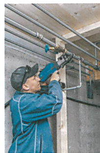
David Kummer stellt innert Sekunden die Verbindungen her. | David Kummer réalise l'assemblage en quelques secondes.
