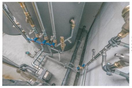
Kugelhahnen aus Rotguss mit Pressanschluss in der Heizungsleitung. | Robinets d'arrêt à bille en bronze avec raccordement serti dans la conduite de chauffage.
