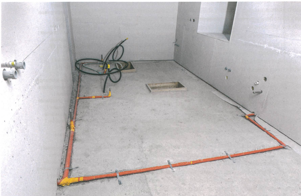
Die Gasleitung im Küchenrohbau. | Conduite de gaz dans le gros œuvre de la cuisine.
