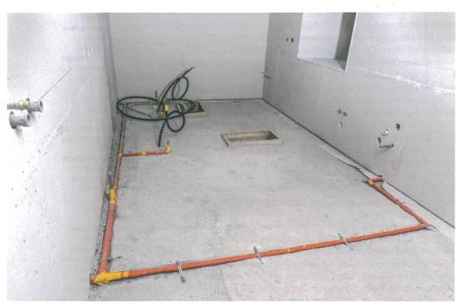
Die Gasleitung im Küchenrohbau. | Conduite de gaz dans le gros œuvre de la cuisine.
