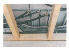
Steigleitung mit Abgang auf Etagenverteilung. | Colonne montante avec départ sur la distribution d'étage.
