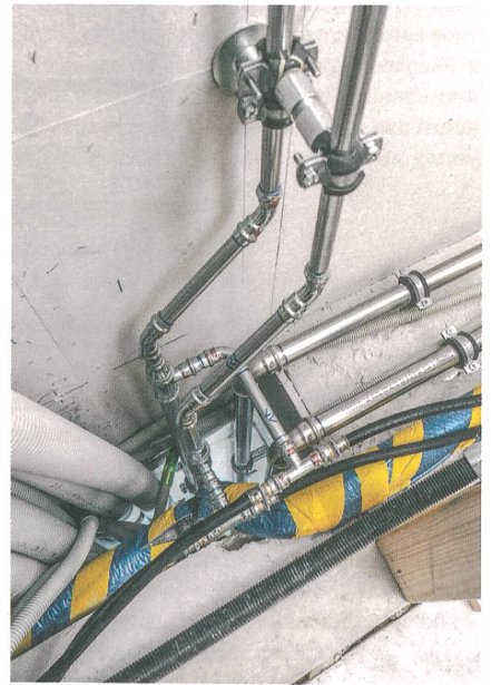
Hier kommen Heizung, Solarenergie und Wasser im Leitungsschacht zusammen. | Les conduites solaire côtoient celles destinées au chauffage et à l'eau dans la gaine.
