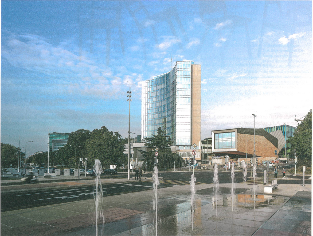
Das Hochhaus am Platz der Nationen in Genf hat Zuwachs bekommen: einen grossen Konferenzsaal, verkleidet mit Holzschindeln.
