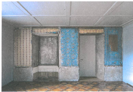
Sichtbare Vergangenheit: Die Architekten holten die alten Tapeten und zugemauerten Fenster hervor. Die Türen zum Neubau legten sie unter den alten Stürzen an.
