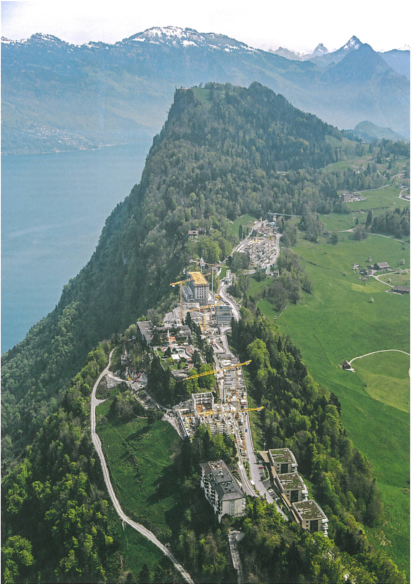
Baustelle hoch über dem Vierwaldstättersee: 2017 sollen auf dem Bürgenstock 800 Hotelbetten, 68 Ferienwohnungen und ein Gesundheitszentrum in Betrieb gehen.
