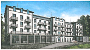
Grand-Residence-Suiten: Neubau auf dem Grundriss des ehemaligen Grandhotels, Gestaltung in Anlehnung an den ursprünglichen Pionierbau von 1873. 30 Residenzsuiten. Architektur: Rüssli Architekten, Luzern Interior Design: MKV, London
