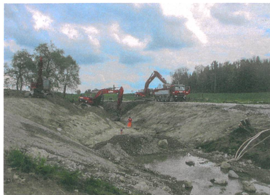
Nachher: Die Böschungen sind abgeflacht, das Bachbett ist aufgeweitet.
