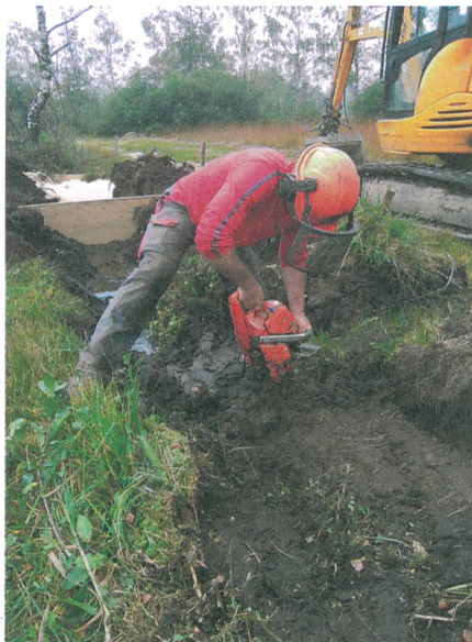
Mit der Motorsäge werden Schlitz in Querrichtung in die Torfgräben geschnitten und anschliessend Holzschalttafeln eingerammt.
