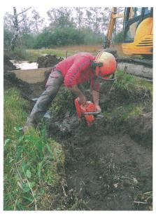
Mit der Motorsäge werden Schlitze in Querrichtung in die Torfgräben geschnitten und anschliessend Holzschaltafeln eingerammt.
