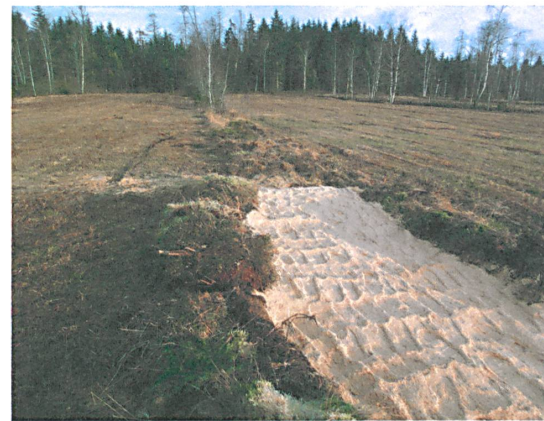
Ist das Sägemehl festgestampft, werden die Gräben mit den ausgestochenen Plaggen abgedeckt. Unterhaltsarbeiten sind keine nötig.
