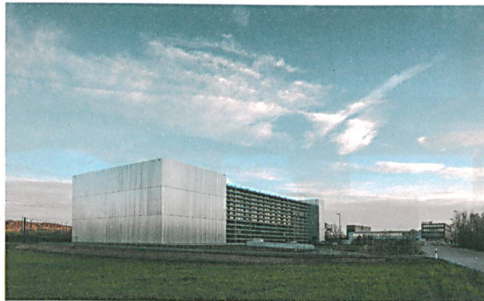
Treppenturm und Hochregallager sind mit Trapezblech verkleidet.
