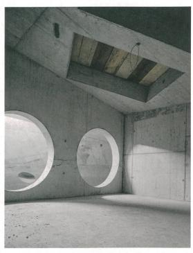
Keine Bullaugenfenster, sondern Löcher für die Rauchgasventilatoren. Im Dach klafft eine temporäre Öffnung. Durch sie werden die Schalungen nach Abschluss des Rohbaus aus dem Gebäude transportiert.
