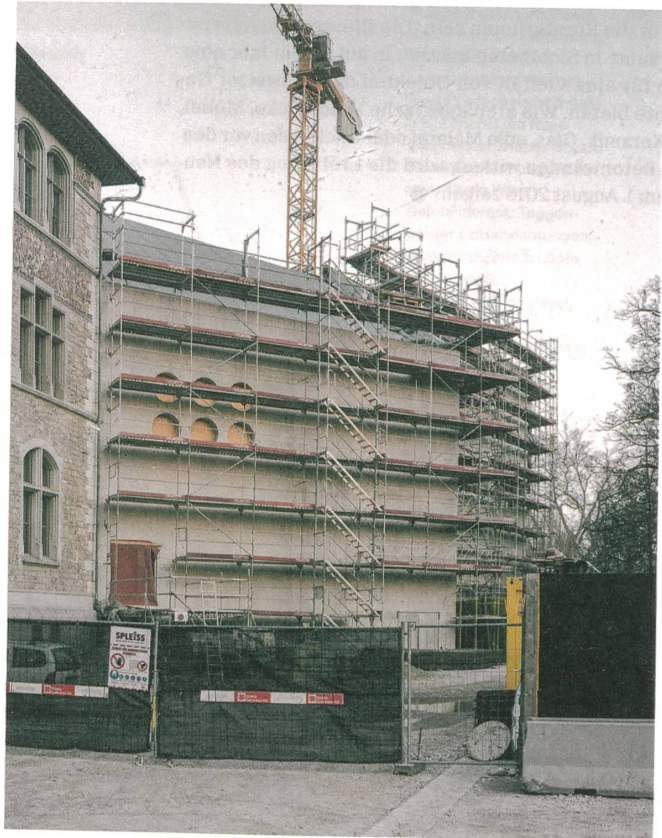
Die Bullaugenfenster wurden aus der Betonwand herausgefräst.
