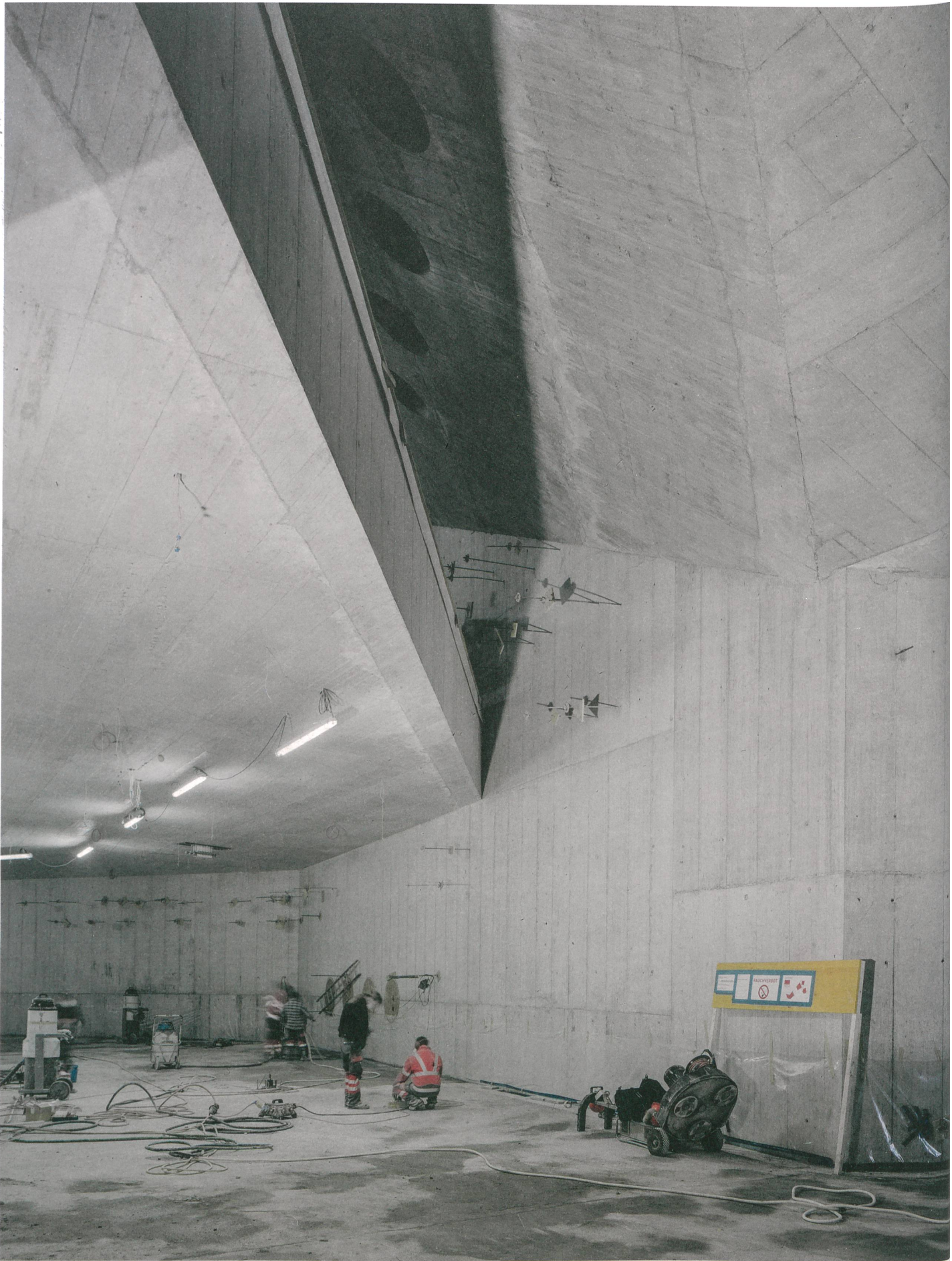
Ausstellungsraum im ersten Obergeschoss: Die Böden werden geschliffen, auf den Innerwänden bleibt das Schalungsbild sichtbar.
