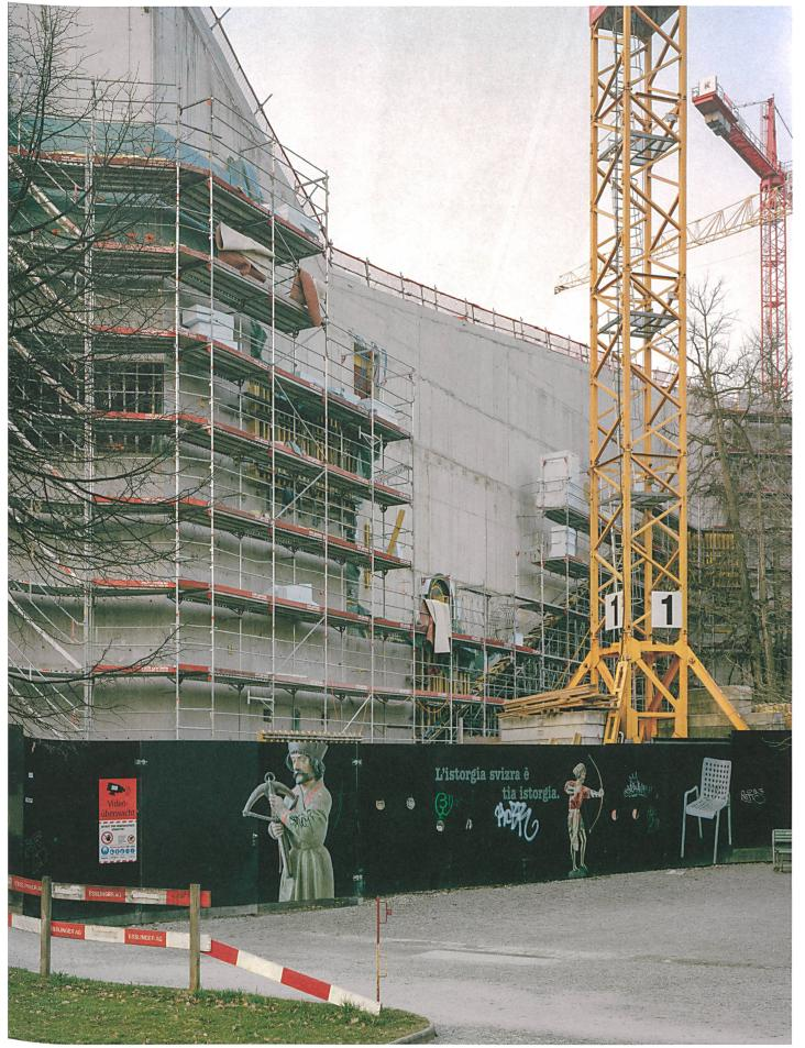
Abgetreppter Betonierablauf: Die fugenlose Aussenschale wird etappenweise von unten nach oben gegossen. Nur so kann der Beton gleichmässig verdichtet werden.
