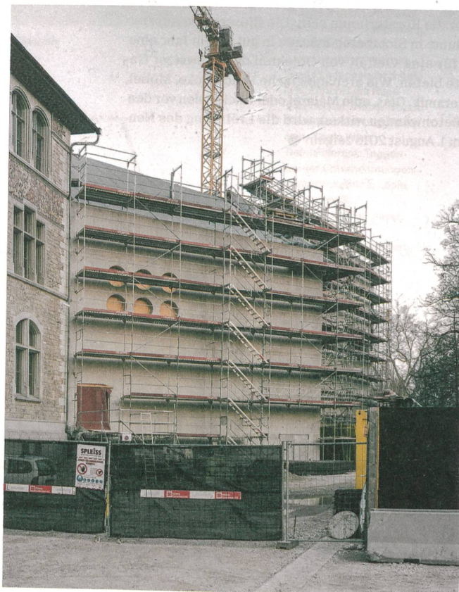
Die Bullaugenfenster wurden aus der Betonwand herausgefräst.
