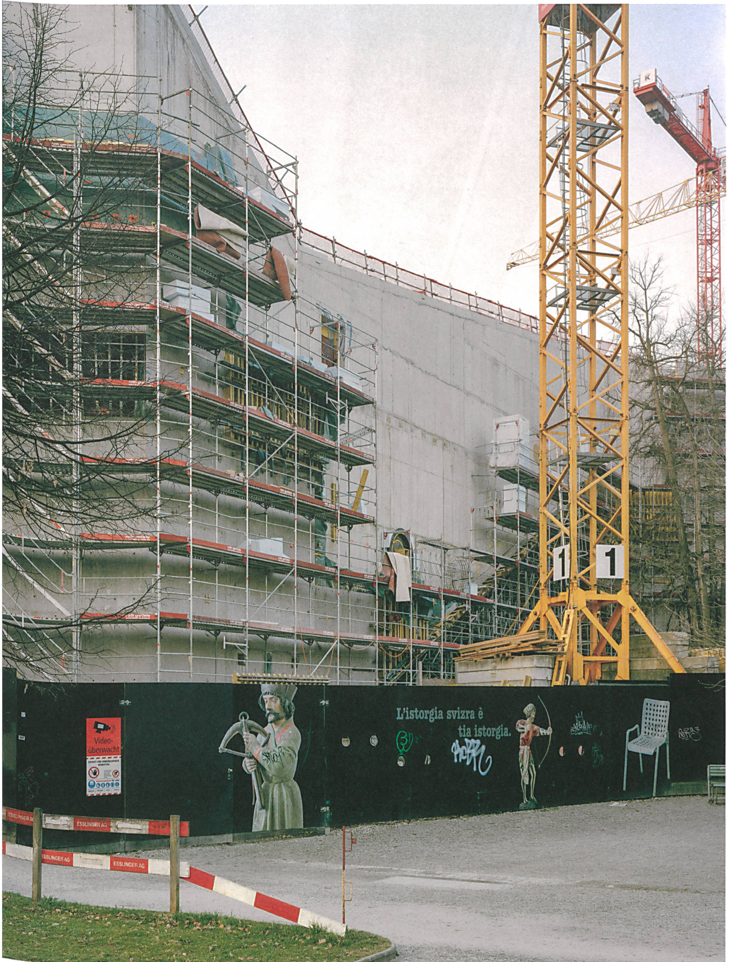
Abgetrepter Betonierablauf: Die fugenlose Aussenschale wird etappenweise von unten nach oben gegossen. Nur so kann der Beton gleichmässig verdichtet werden. ...
