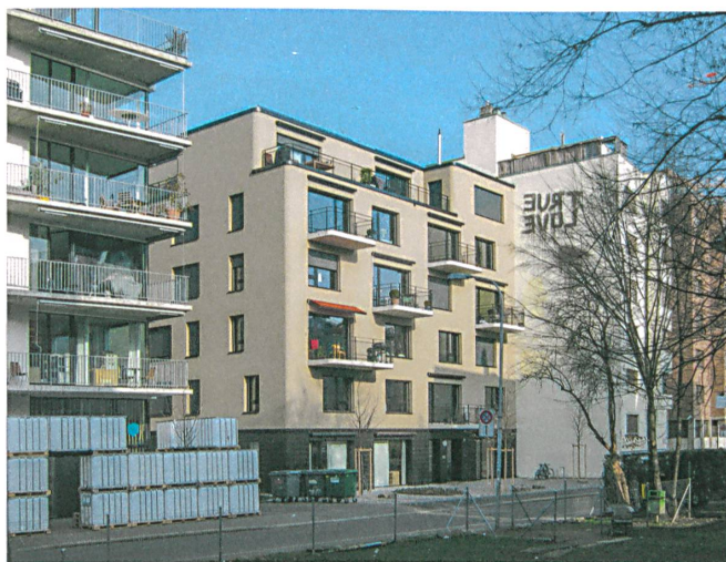
Rechts schliesst das Haus an den Nachbarn an, links blickt man vorbei auf das Gleisfeld.
