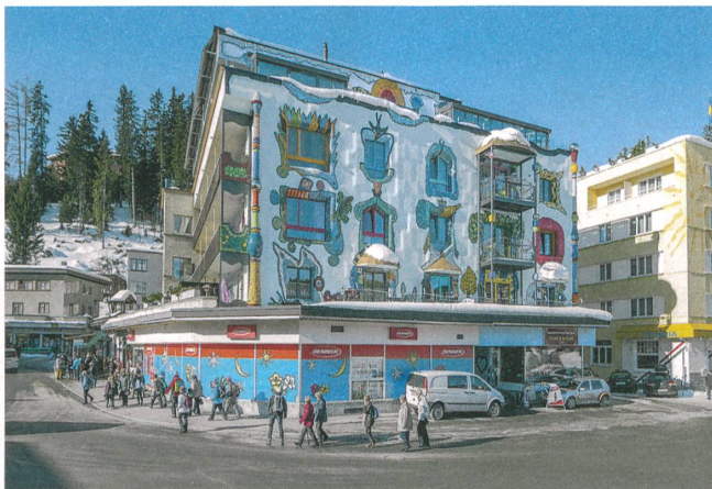
Das Haus Hold im Hundertwasser-Stil «renoviert». Daneben das frühere Posthotel – auch ein Beispiel des Neuen Bauens.
