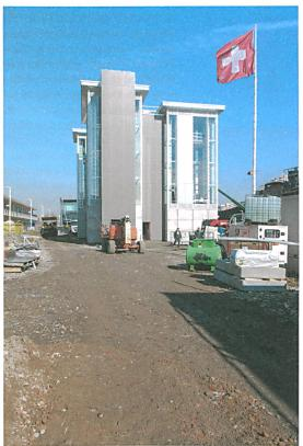
Anders als geplant ist die Konstruktion der Türme nicht in Holz, sondern in Beton realisiert worden. Foto: Netwerch
