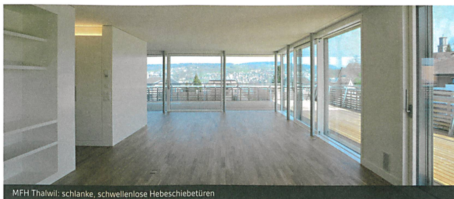
MFH Thalwil: schlanke, schwellenlose Hebeschiebetüren
