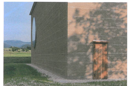
Horizontale Schichten aus Trassston verhindern, dass die Fassade zu stark erodiert.
