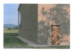
Horizontale Schichten aus Trasston verhindern, dass die Fassade zu stark erodiert.
