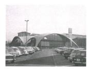
Heinz Islers Betonschalen sind legendär: im Bild die Kuppel für den Feuerlöscherfabrikanten Sicli in Genf, erbaut 1969. Foto: GTA-Archiv, Nachlass Heinz Isler
