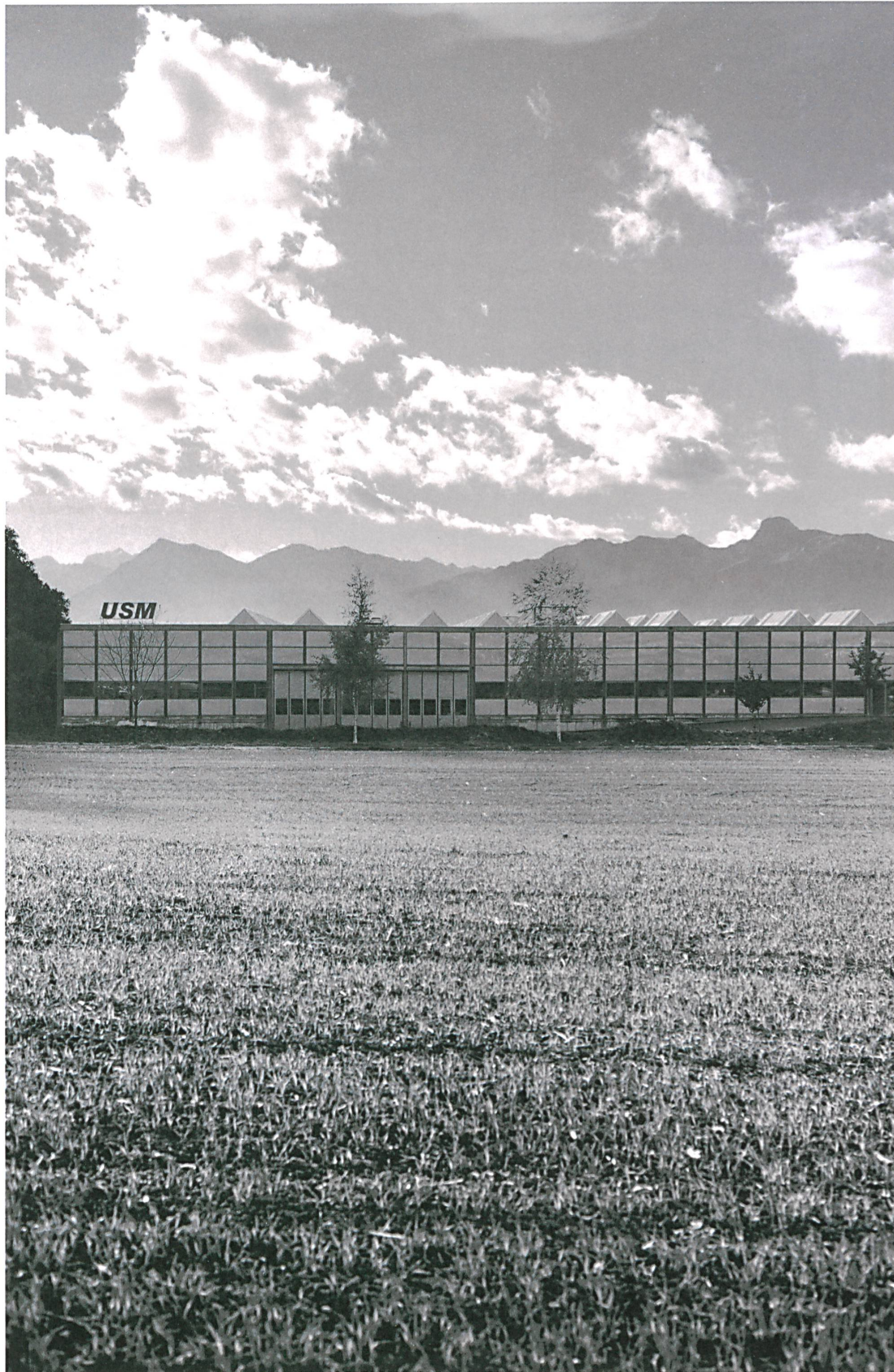
Fritz Haller entwickelte in den Sechzigerjahren das System USM für den Bau von flexiblen Gewerbe- und Industriebauten: Hier das Produktionshaus von USM in Münsingen von 1964. Foto: USM Möbelbausysteme
