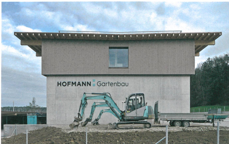
Die leichte Auskragung des Obergeschosses zeigt: Dahinter verbergen sich die beheizten Räume.
