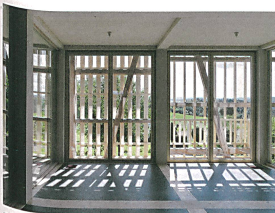
Die Bretter und Latten der Aussenschale dimmen Ein- und Ausblicke.
