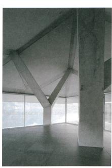
Das Stabwerk aus Dachrippen und leicht asymmetrischen Y-Stützen ist mit vorfabrizierten Elementen vergossen.
