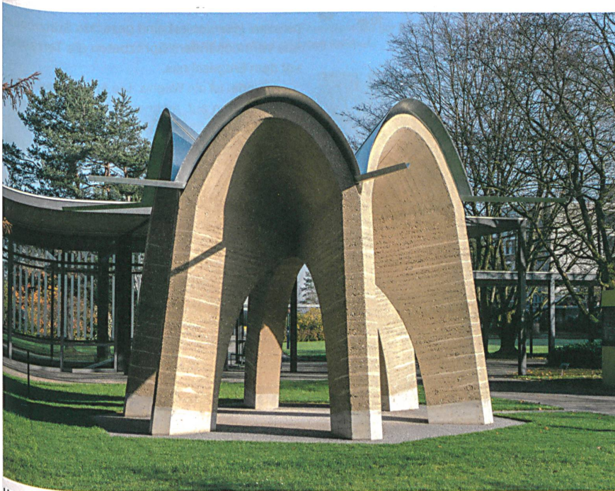
Unten schützen Betonfüsse, oben ein Blechhut: Stampflehm auf dem ETH-Campus Hönggerberg.
