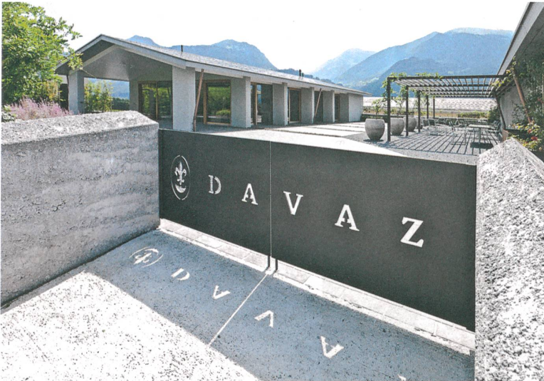
Das Weingut Davaz in Fläsch hat einen Neubau erhalten, der ganz auf die Arbeitsabläufe abgestimmt ist.
