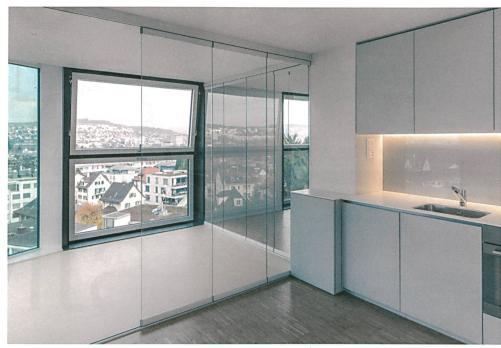
Das vollverglaste Jahreszeitenzimmer mit wasserdichtem Boden lässt sich luftdicht vom Rest des Wohnraums abtrennen.
