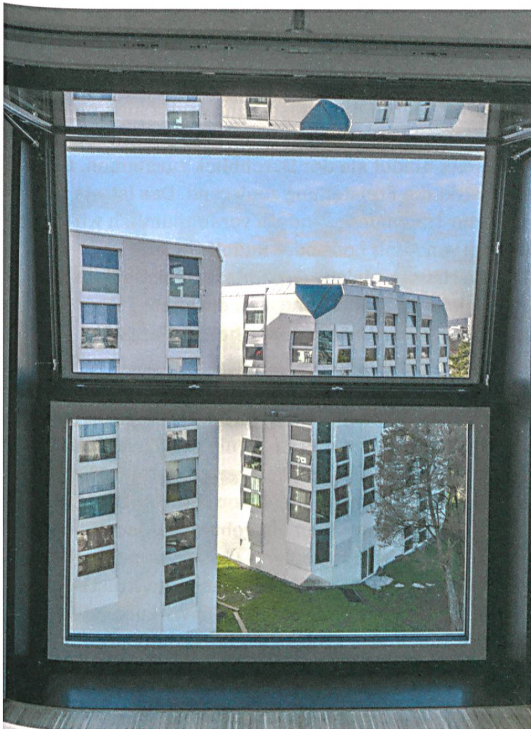
Das raumhohe Klappfensterelement macht Brüstungs- und Sturzdetails überflüssig und integriert Sonnenschutz und dezentrale Luftzufuhr.
