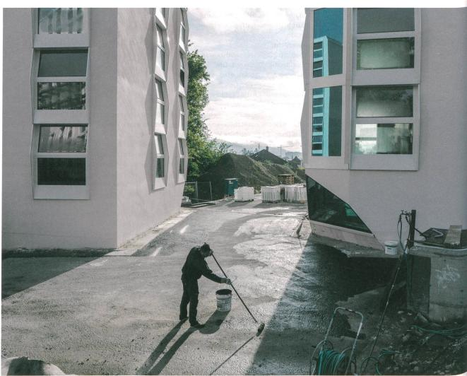
Weil die Proportion der Baukörper beinahe einer Würfelhälfte entspricht, entwarfen die Architekten abgefaste Kanten und abgeschnittene Ecken aus Sonnenschutzglas.
