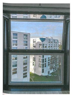
D<sub>as</sub> raumhohe Klappfensterelement macht Brüstungs- und Sturzdetails <sup>Übe</sup>rflüssig und integriert Sonnenschutz und dezentrale Luftzufuhr.
