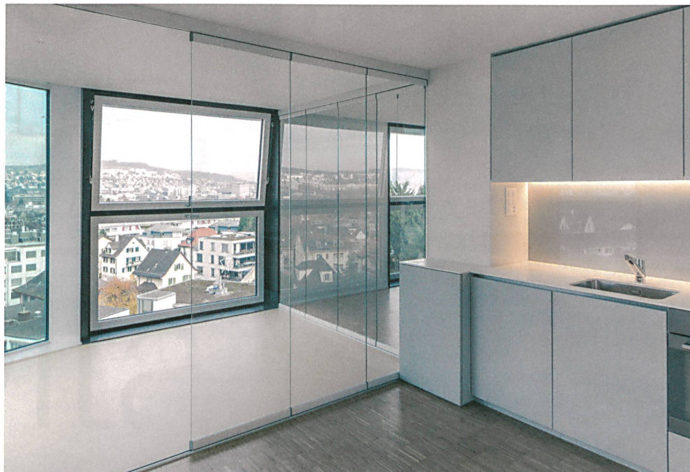
Das vollverglaste Jahreszeitenzimmer mit wasserdichtem Boden lässt sich luftdicht vom Rest des Wohnraums abtrennen.
