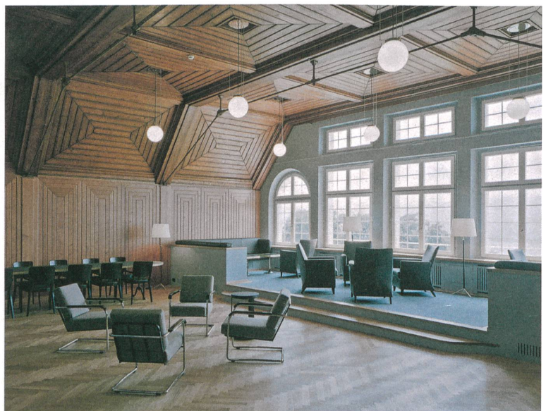
Kassettendecke mit Zugstäben aus Metall im ehemaligen Andachtsraum. Foto: Georg Aerni
