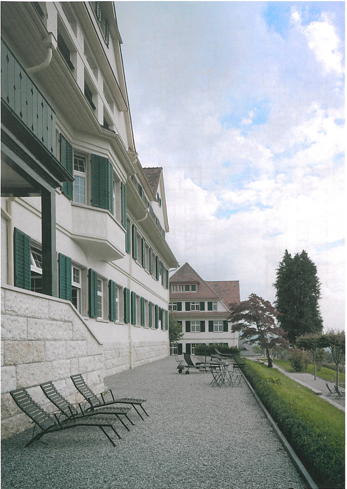
Äusserlich haben sich die Altbauten wenig verändert: Die Fassade wurde behutsam saniert und, wo nötig, ergänzt. Die neue Gartenanlage erstreckt sich über zwei Terrassen.
