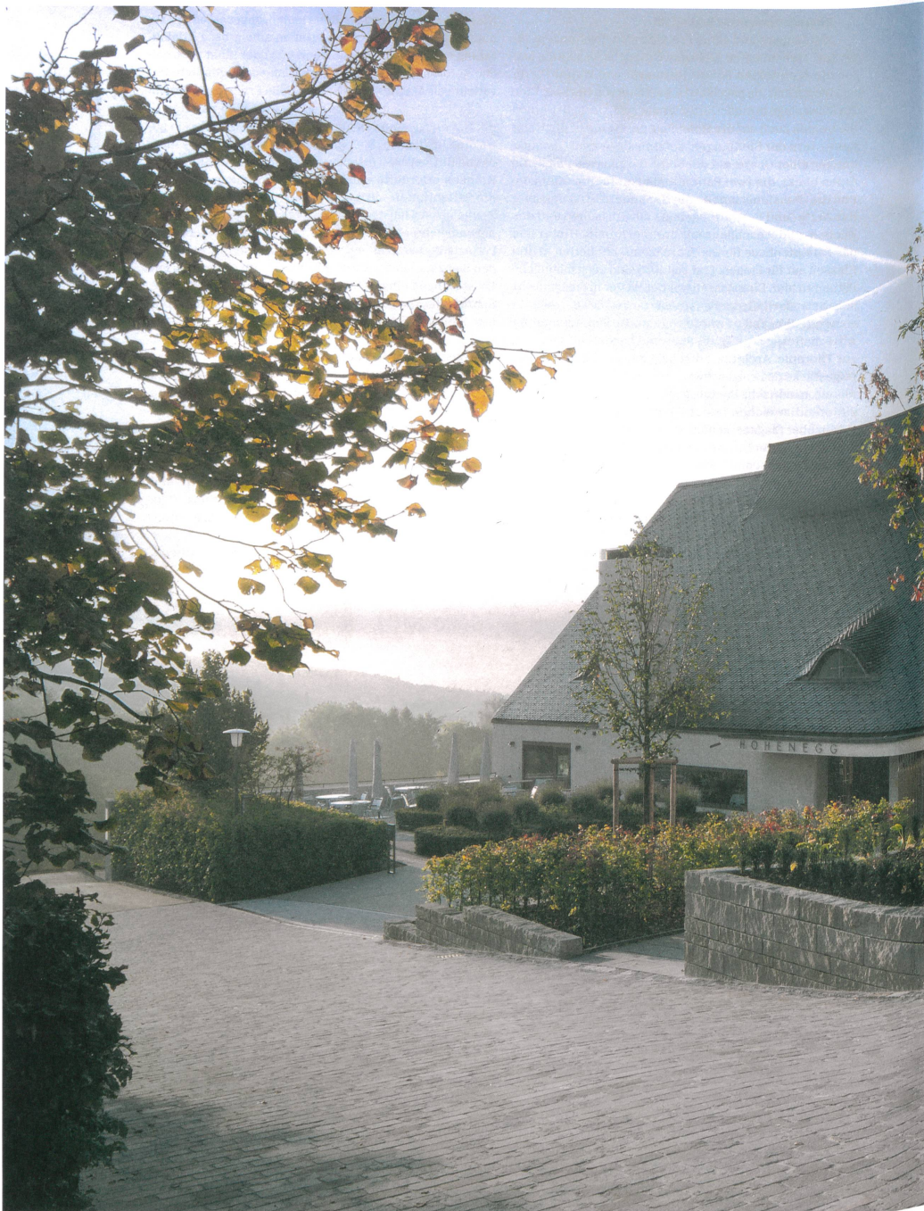
Das neue Empfangs- und Restauranthaus. Davor die frisch gepflästerte Gasse. Der Vorgarten mit Mauern, Zier- und Obstbäumen ist neu aufgebaut. Foto: Karin Gauch / Fabien Schwartz
