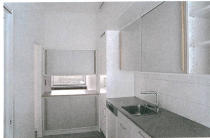
Neue Küche im ursprünglichen Grundriss. Auch die Eschenleisten an den Schiebetürchen sind wieder da.
