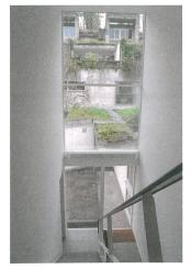
Der PVC-Handlauf des Treppengeländers ist rekonstruiert. Die Fenster in der Nordfassade sind rahmenlos eingesetzt.
