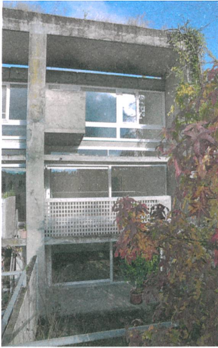
Südfassade des sanierten Hauses in der Halen-Siedlung bei Bern. Die Fensterfrage ist gelöst.
