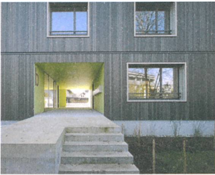
Das Hochparterre schützt das Haus vor Hochwasser.
