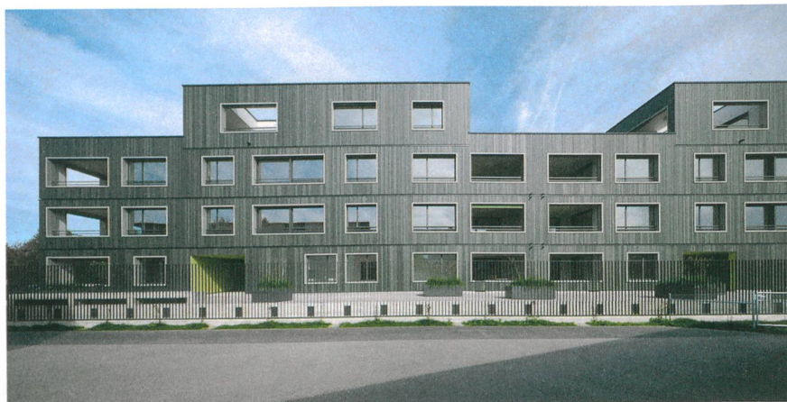
Die horizontalen Linien zwischen den Geschossen deuten an: Dieses Haus besteht aus vorfabrizierten Elementen.
