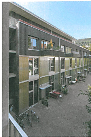
Das Hofhaus: im hellen Sockel die Reiheneinfamilienhäuser, darüber die Geschosswohnungen.
