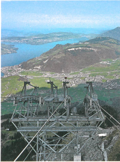
Die Masten am Stanserhorn sind 24 Meter breit.
