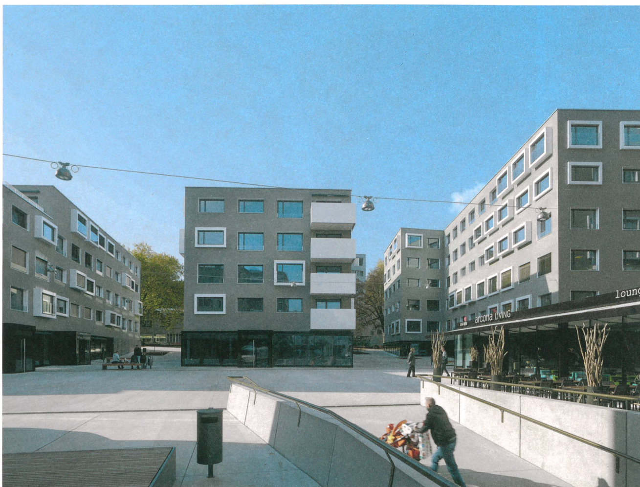
Anstelle der einstigen Stadtallmend umringen fünf Bauten mit öffentlich genutzten Erdgeschossen den Bleicheplatz als Zentrum des neuen Schaffhauser Stadtquartiers.
