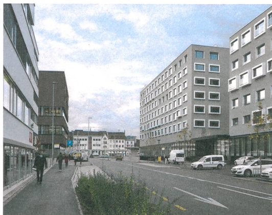
Zur Mühletalstrasse bildet die Überbauung eine für Blicke und Passanten geschlossene Häuserschlucht.
