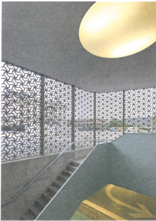
Grosszügige Abgänge bringen viel Licht in die Untergeschosse.
