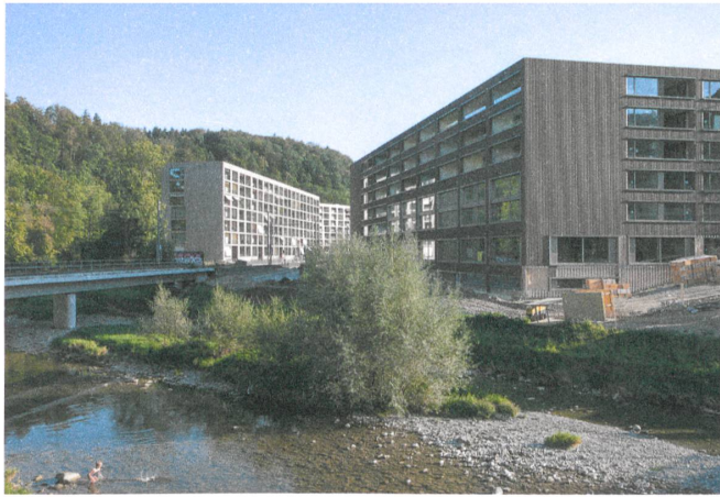
Die Bahnlinie führt zwischen den Scheibenhäusern und dem Hofhaus hindurch ...
