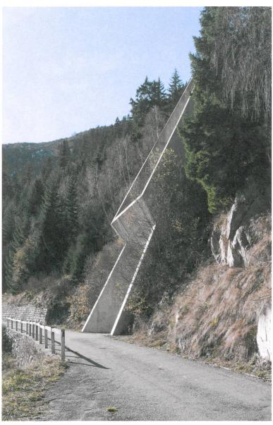
Sedrun: Eine expressive Betonplastik verbindet im Val Naps Entlüftung, Wendeplatz, Lawinen- und Steinschutz.
