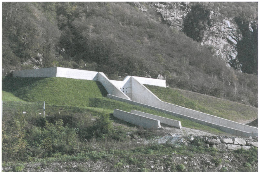
Knoten Giustizia: Kunstvoll wird allfälliges Geröll des Riale Stabiello aufgefangen und an die richtige Stelle gelenkt.
