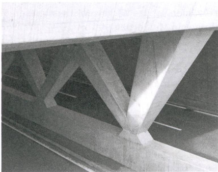
Knoten Camorino: Bei der Unterführung der Kantonsstrasse ist die Zwischenwand in polygonale Kreuzstützen aufgelöst. Sie nimmt so Bezug zu den Stützen der benachbarten Bahnviadukte.
