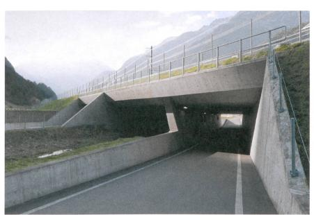
Erstfeld: Die Wanne der Unterführung Rynächt ist im Querschnitt rechteckig, die Flügelmauern entwickeln sich aus den Stützmauern.
