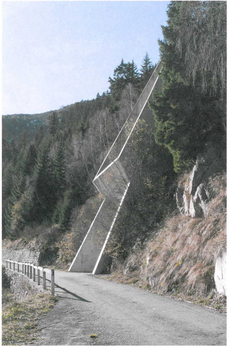
Sedrun: Eine expressive Betonplastik verbindet im Val Naps Entlüftung, Wendeplatz, Lawinen- und Steinschutz.
