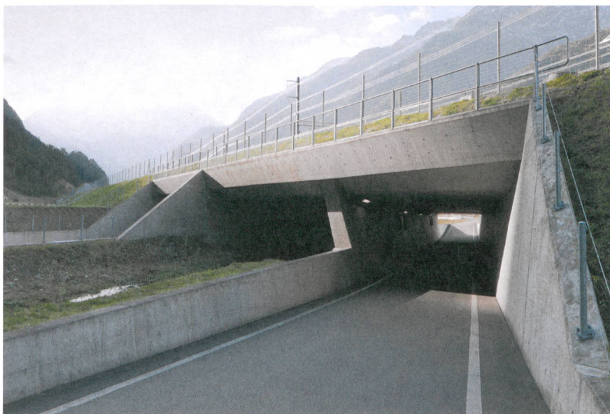
Erstfeld: Die Wanne der Unterführung Rynächt ist im Querschnitt rechteckig, die Flügelmauern entwickeln sich aus den Stützmauern.
