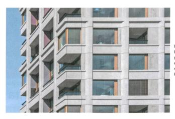
Durch geschicktes Formen und Fügen vorgefertigter Betonteile entstand die spannungsvolle Fassade des Zölly-Hochhauses.
