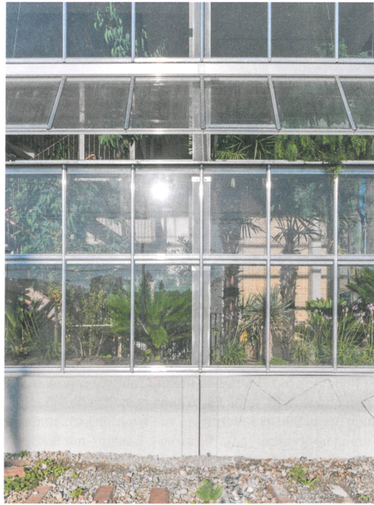
Was hinter dieser Gewächshausfassade in Winterthur schimmert, macht neugierig.
