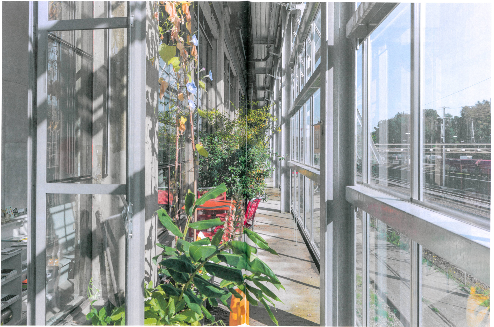
Umgebaute Halle 181 auf dem Lagerplatz in Winterthur: Eine neue Schicht dient als Schall- und Kältepuffer, aber auch als Aufenthaltsraum und botanisches Labor.
