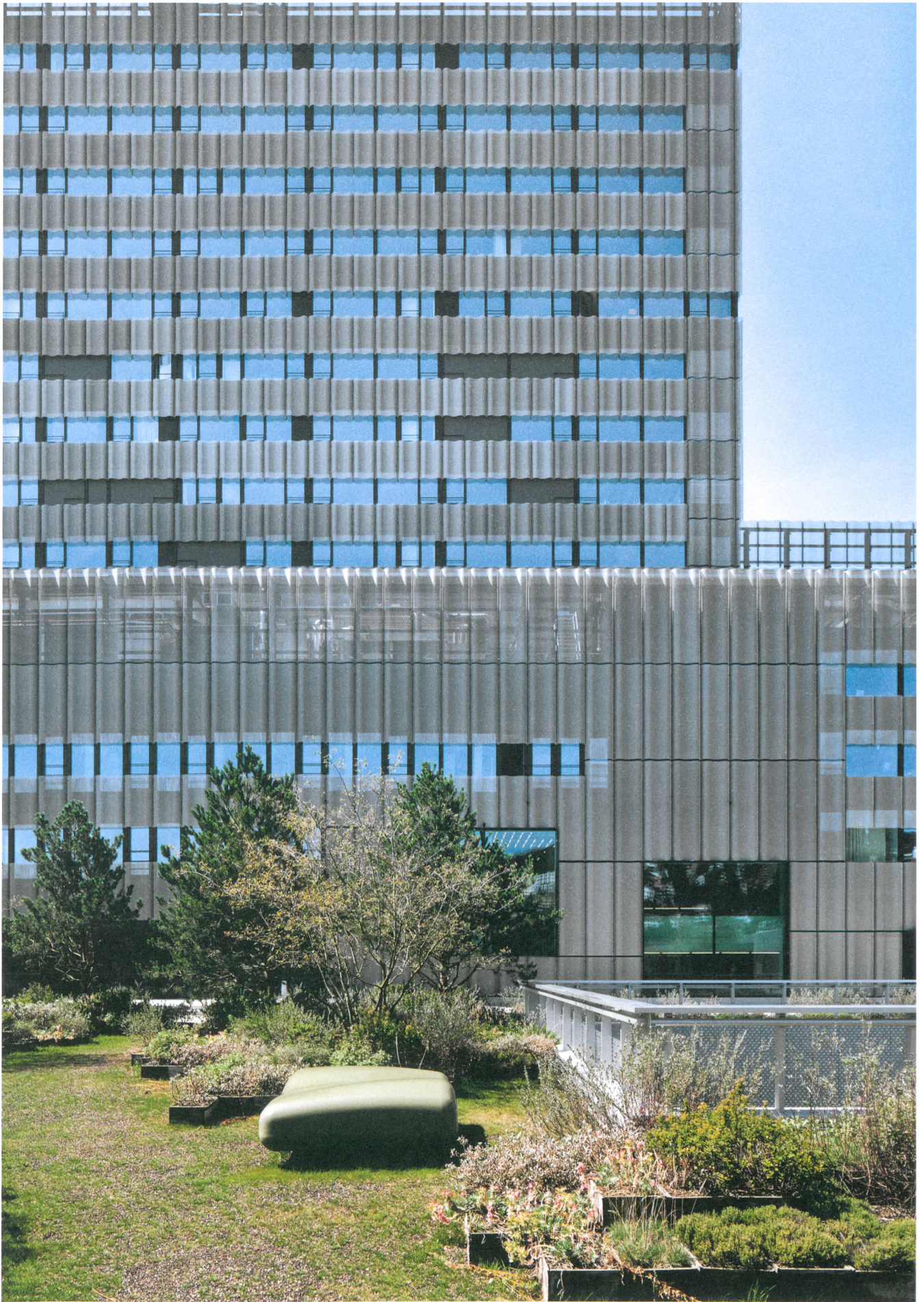
Der 2600 Quadratmeter grosse Dachgarten ist alles in einem: grüner Park, offener Pausenplatz, weite Terrasse, erweiterte Werkstatt, luftiger Kinderspielplatz und auch Flanierzone.
