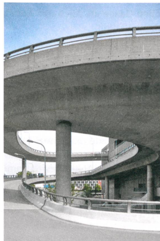
Die Lastwagenrampe wird zum Boulevard.
