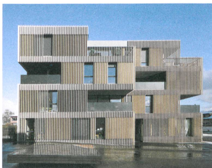
Der Lamellenvorhang ist nicht nur Fassadenverkleidung, er schützt stellenweise auch vor Einblicken.
