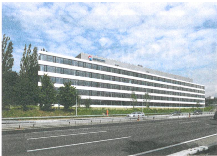
Das Swisscom-Bürohaus am Rand der Stadt Bern gibt sich aussen unscheinbar.
