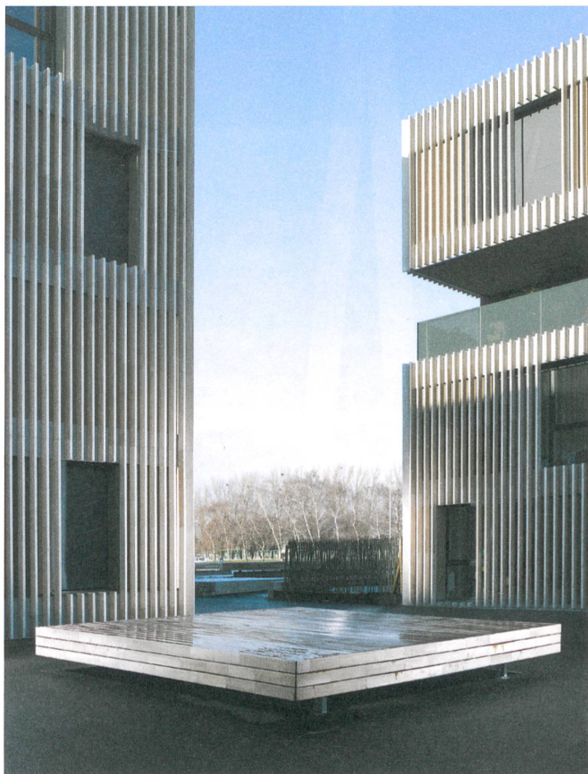
Travertin als Vorhang: die beiden Neubauten in Crans-près-Céligny.
