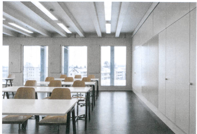
Die Decke der Klassenzimmer zeigt die Tragstruktur, die sich mit den äusseren Stützen verbindet.
