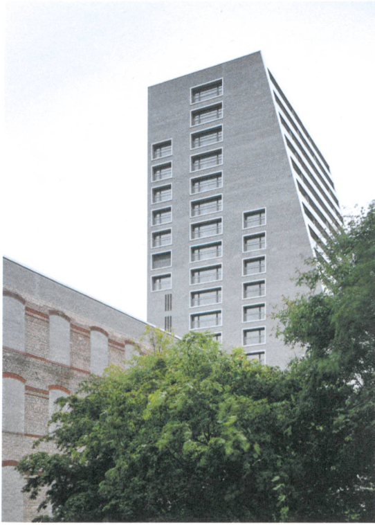
1 Escher-Terrassen: Sehen so eine sorgfältige Gliederung und ein gelungener Bezug zwischen Innen- und Aussenraum aus? Foto: Rasmus Norlander, Stadtplan auf Seite 19.
