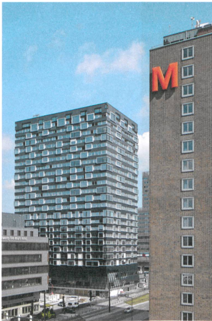
4 Hardturmpark: Das Fenster-Tetris überspielt die gestapelten Nutzungen, ein Röckli dient als Vordach. Foto: Roger Frei
