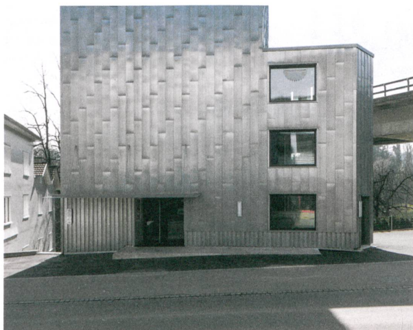
Titanzinkplatten und Wellblechsockel dienen als Panzer im unwirtlichen Kontext.
