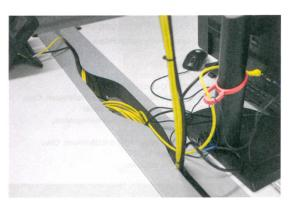
Die aluminiumfarbene Kabelkanalbox fasst die Kabel zwischen den fest installierten Arbeitsplätzen.
