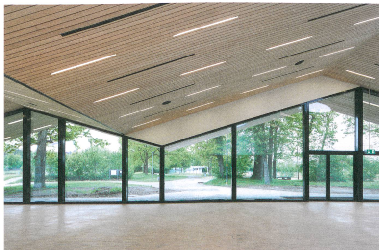
Alles unter einem Dach: Die gefaltete Decke bestimmt den Bau und nimmt die Technik auf.
