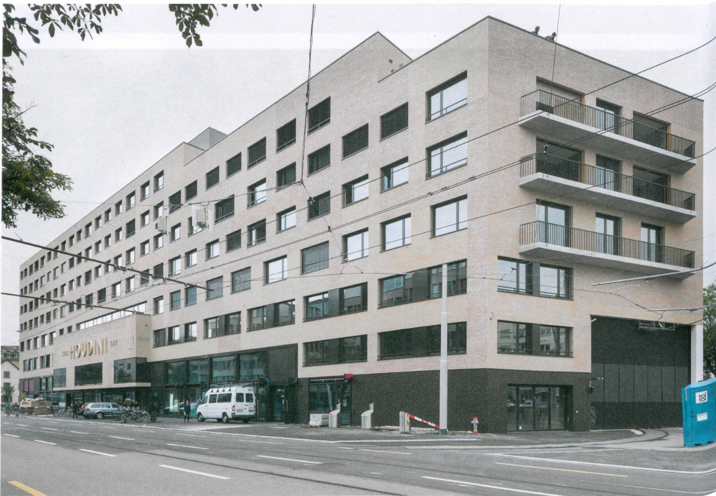
Die Fassade, hier zur Badenerstrasse, wirkt dünnhäutig und beliebig mit Balkonen, Erker, Abtreppungen und ihrer Farbigkeit. Foto: Standort 1 – siehe Plan, Seite 41.
