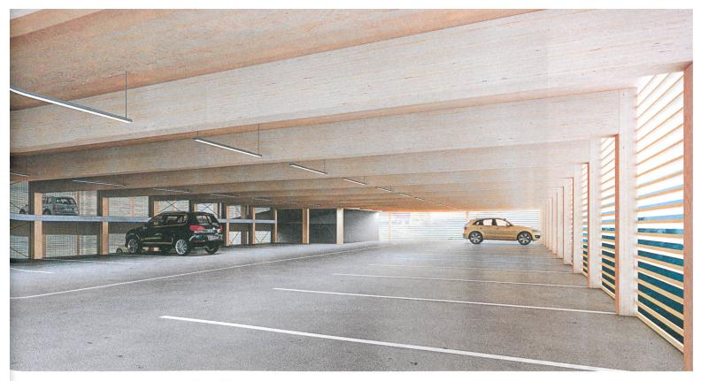
Parkhaus als konstruktiver Holzbau mit BauBuche, Unterzüge und Stützen aus BauBuche GL7o, Deckenuntersicht aus BauBuche Platten.
