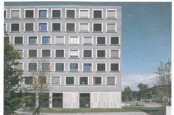
Versetzte Fenster mit Putzlaibungen und Betonfensterbänken überspielen die immer gleichen Studentenzimmer zur Hofseite.
