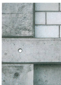
Das Tragwerk aus Ortbeton ist teils mit Kalksandsteinmauerwerk ausgefacht.
